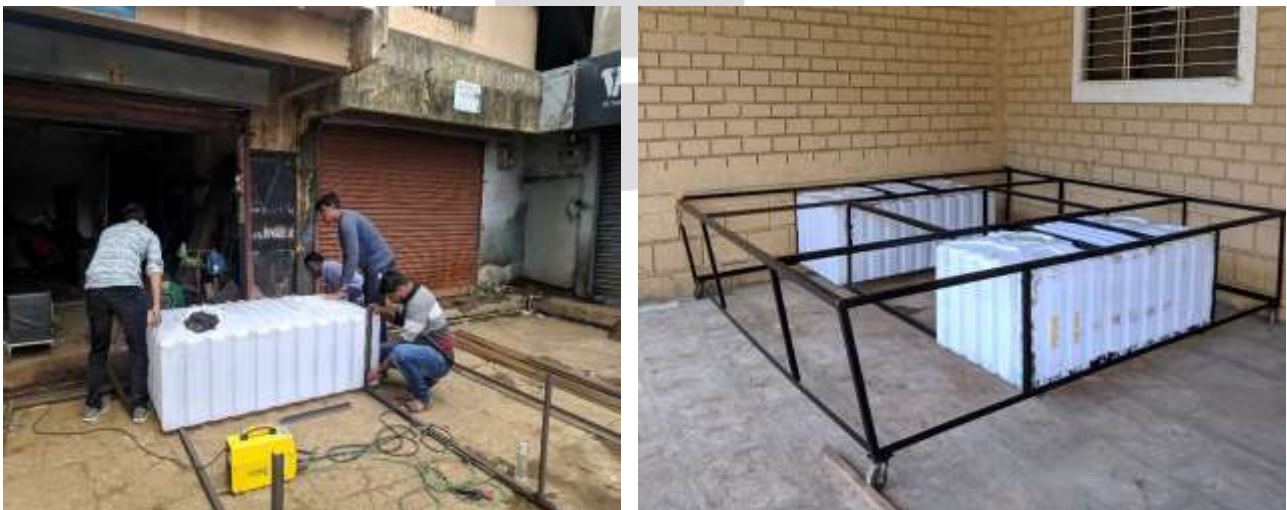
Fig No.4 Actual Frame Welding
